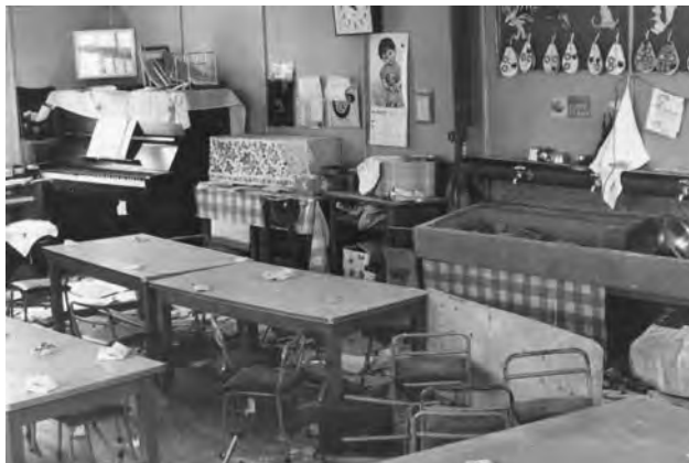
5月16日9時49分、十勝沖地震により園舎に大きな被害を受け、約2週間臨時休園となりました
