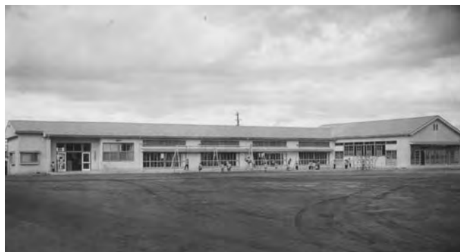
11月 独立園舎（保育室4、遊戯室他 500㎡）類家に完成
