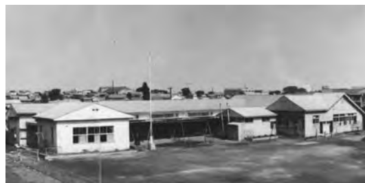
5月 保育室・職員室・昇降口など(113㎡)を増築
